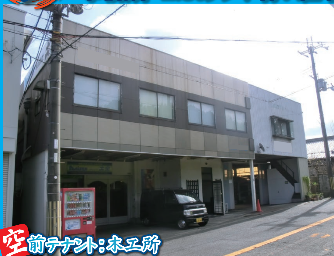
【1階:倉庫・工場】
